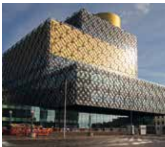
Biblioteca di Birmingham Regno Unito
